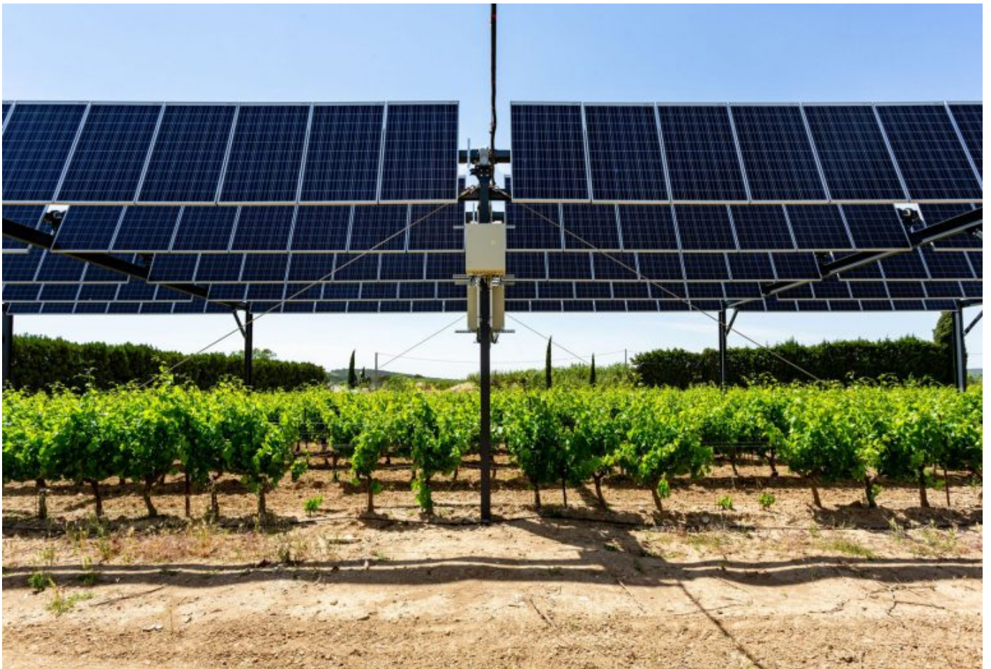
Système d'agrivoltaïsme sur vigne. Copyright : Bruno CLAESSENS
